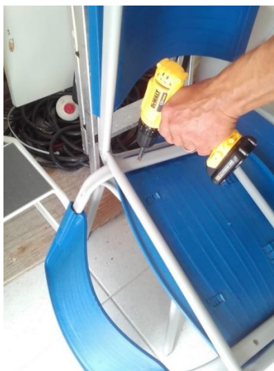
Reparo nas cadeiras
